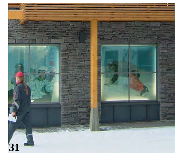
Kuva 31. Esimerkki kivijalkakerroksen verhoilusta maanpintaan saakka.
