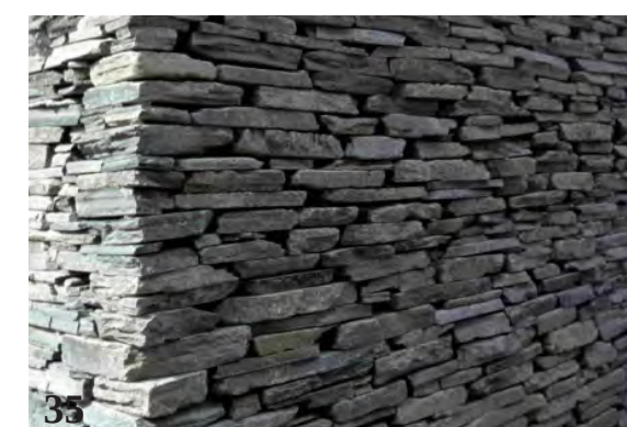
Kuva 34: Hirsipaneelia. Kuva 35: Luonnonkivimuurausta.
