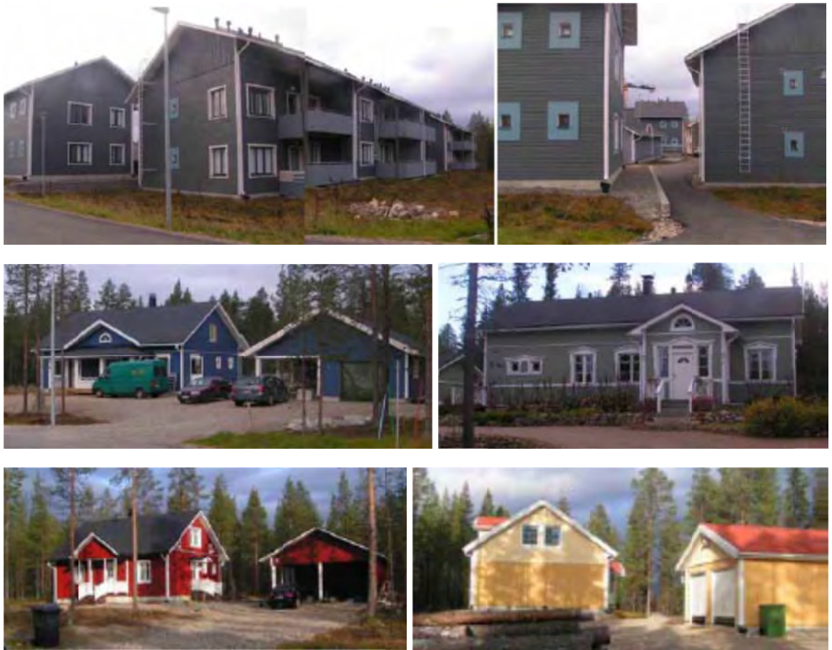
Kuva 4. Esimerkkejä nykyisestä rakennuskannasta
