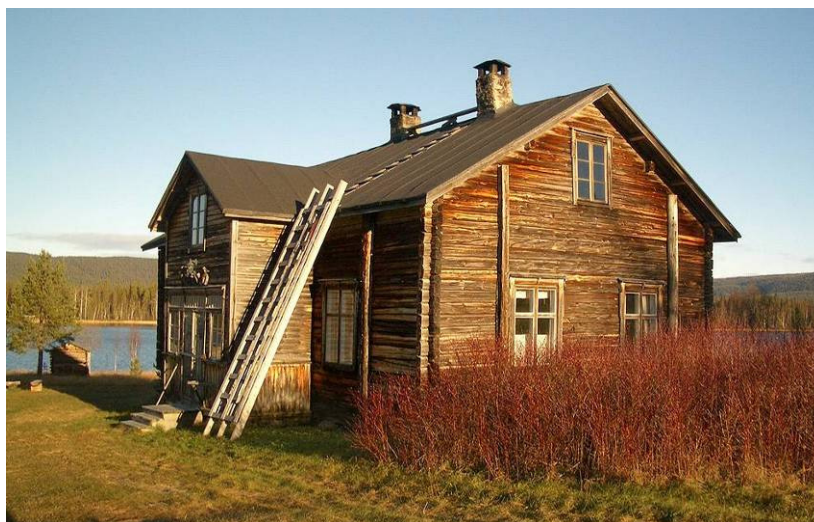
Kuva 18. Kätkälän päärakennus. Pihapiiriin kuuluu myös aitta, josta vanhin löytynyt vuosiluku on 1801 39 . (Kuva: Eeva Heikelä)
