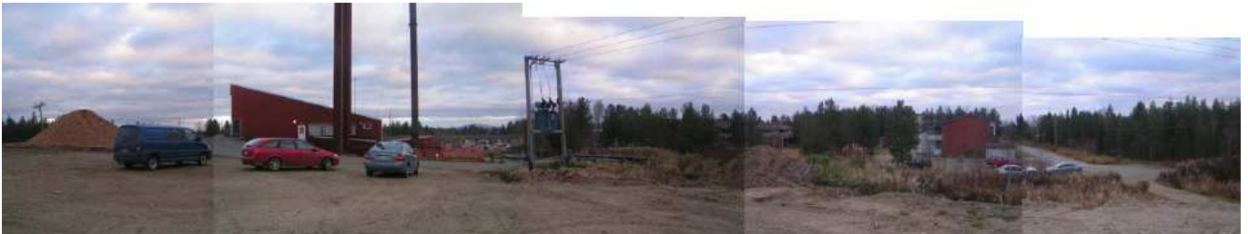
Kuva 4 Näkymä Aluelämpölaitoksen pihalta
