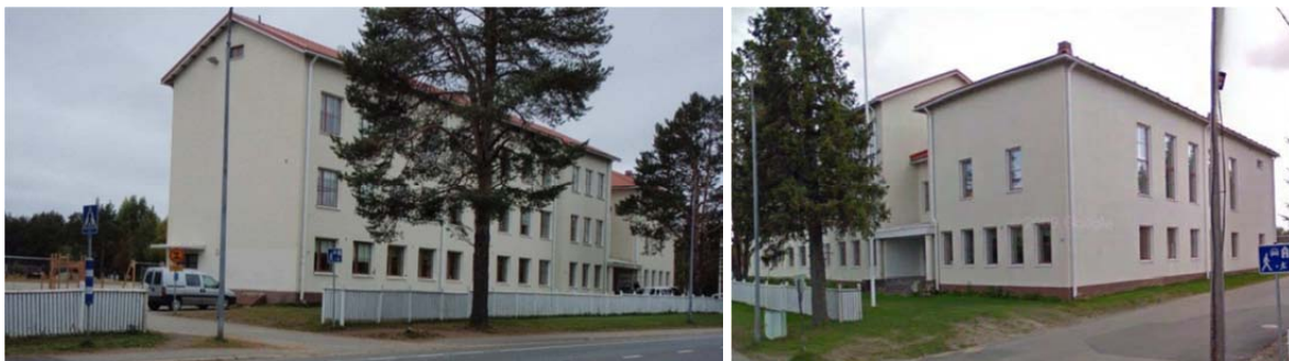
Kuva 4. Lukkarin koulu (kuvat: Google Street view)
