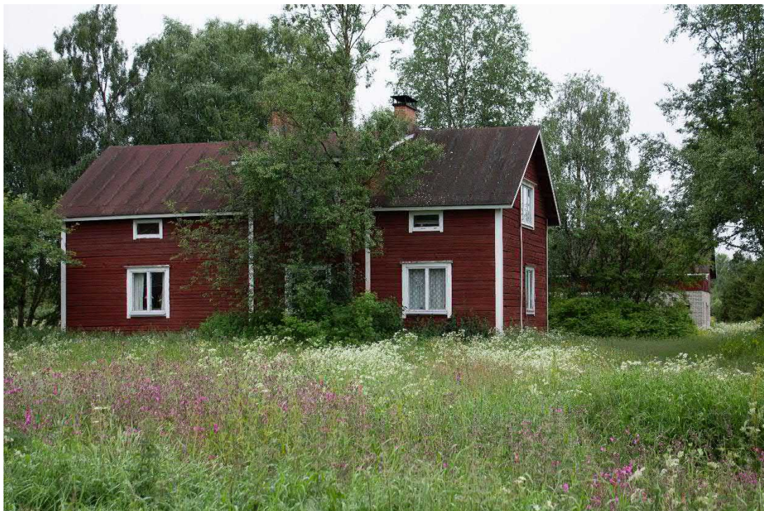
Kuva 14. Viehättävä pihapiiri. Päärakennusta vastapäätä kivinavetta (Mari Lampinen/FCG).
