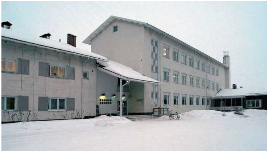
Kuva 8. Entinen emäntäkoulu (kuva osayleiskaavan rakennusinventointiraportista)
