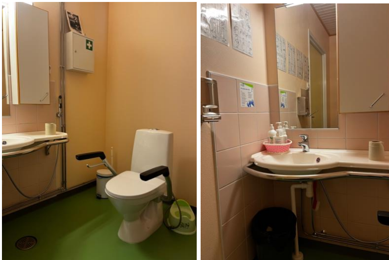
5 Wc-istuimelle mahtuu siirtymään oikealta puolelta. Käsienspesualtaan alle mahtuu hyvin
