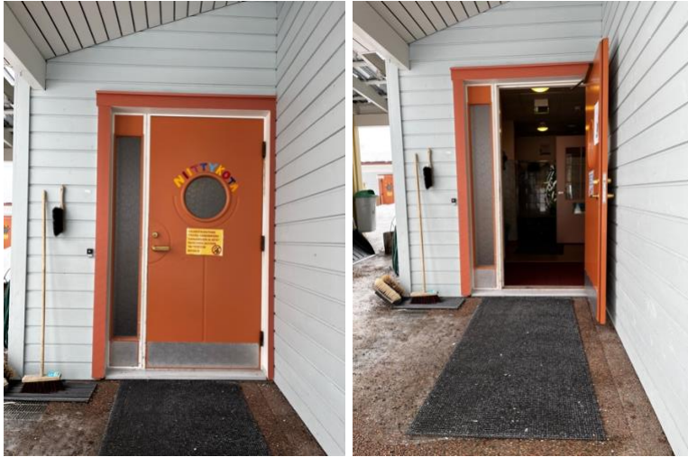
2 Ryhmien sisäänkäynnit ovat katoksissa ja tasaisia. Kynnykset ovat korkeita.
