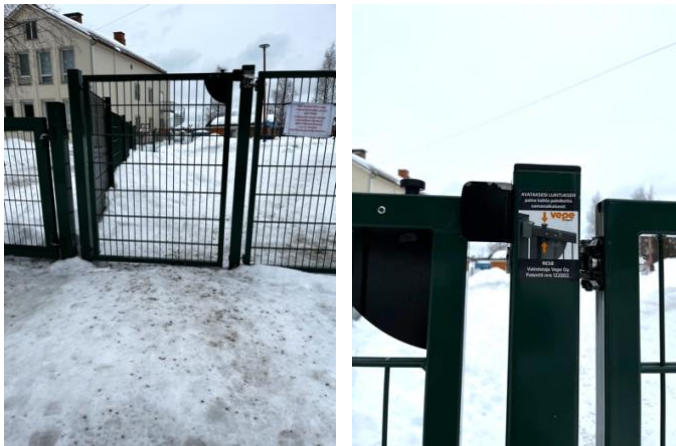
1 Pihaan kuljetaan portin kautta. Portin mekanismia käytetään yhdellä kädellä. Mekanismi on korkealla
