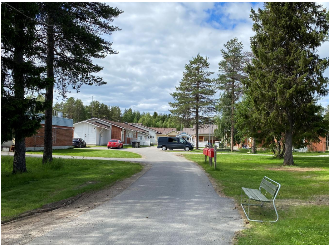
Kuva 4 Pääskylänniemen palvelutaloja kuvattuna kesällä 2021.
