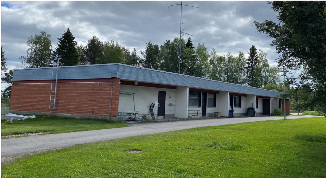
Kuva 5 Pääskylänniemen rivitalot ovat kärsineet tulvavahingoista.
